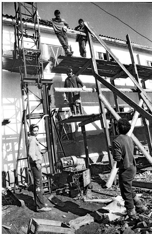
Рис. 4. Стройка в с. Нунлингран, 1985. Фото Н. Н. Боброва
